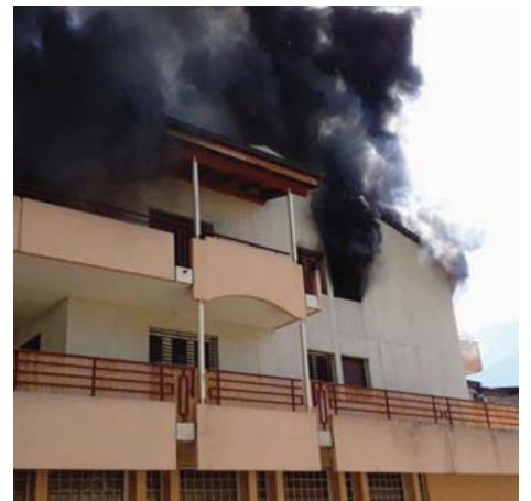
Le brasier qui s'est propagé à la toiture a été maîtrisé vers 14 h 30.
